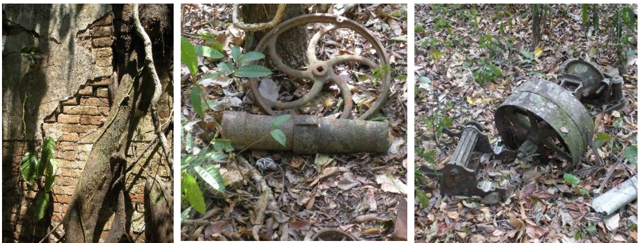
Fig. 5.- Vestigios de la central de la Casa Romano La Constancia en el Río Tzendales, donde se observan algunos muros, pisos y columnas, así como piezas de maquinaria utilizada en la montería (Imágenes: I.J. March Mifsut).
